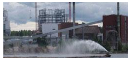
ТЭЦ на биомассе, Kaukaan Voima Oy, Финляндия. ТЭЦ производит электрическую энергию и тепловую энергию для целлюлозно-бумажного комбината UPM-Kymmene Oyj Kaukas.
