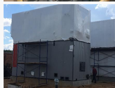
Строительство котельной на местных видах топлива в городе Щучине Гродненской области Суммарная мощность – 12 МВт
