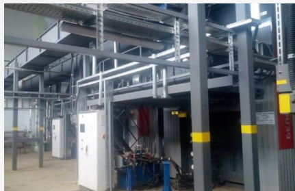
Строительство котельной в деревне Боровляны с установкой котлов на местных видах топлива Суммарная мощность – 21 МВт
