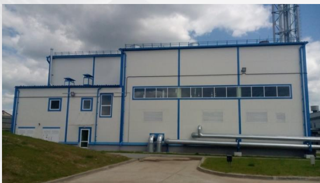
Строительство котельной в деревне Боровляны с установкой котлов на местных видах топлива Суммарная мощность – 21 МВт
