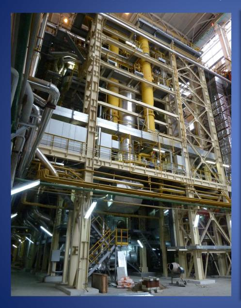
В состав котельного отделения входят три паровых котла типа E-220-9,8-540 ГД производства Барнаульского котельного завода:
